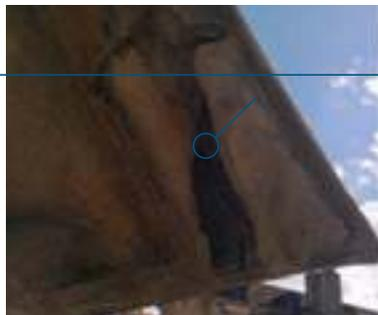
Les ferblanteries des contreforts sont en mauvais état général. Certaines sont en plomb et présentent des fissurations, des déchirures au niveau des soudures qui provoquent des micro infiltrations d'eau sur les parements en pierre qu'elles sont censés protéger.
