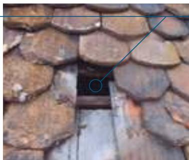
Les encaissements supérieurs en cuivre présentent de nombreuses soudures défectueuses. De même sur les certains points de fixations, la tête des vis de fixations gonflent sous la corrosion avec le risque d'éclatement ponctuel des pierres situées en dessous.
