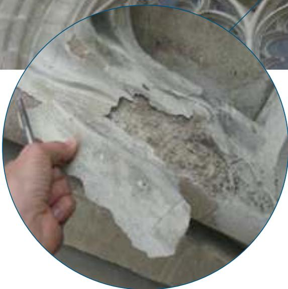
L'état des parements en molasse sur certaines parties de façade exposée et dont les joints en ciment retiennent une humidité excessive dans leur partie extérieure qui finit par se surcharger en sels avec des effets de boursoufflures marquées.
