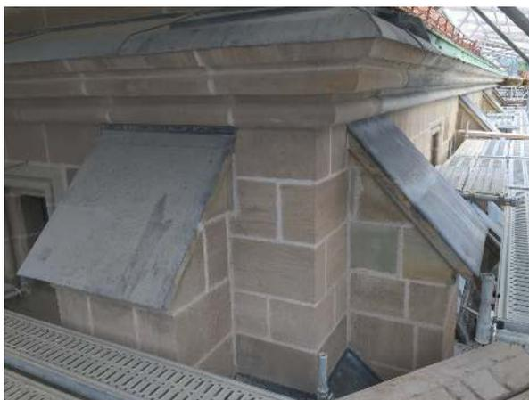
Les nouvelles ferblanteries sont faites en cuivre étamé à la main, la finition après quelque temps d'exposition aux intempéries sera proche de celle existante en plomb.
